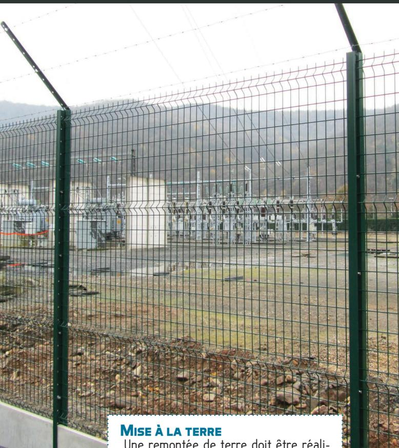
Réalisable sur demande, la **CLOTURE E.D.F Treillis Soudé** est constituée de panneaux **PLIS 105 6/5** (maille 100x50) fixés par brides sur poteaux **CLOPLUS** en aluminium thermolaqué. Elle dispose d'un soubassement en plaques béton de 50 cm, semi enterrées.. Elle est disponible en 2 types : Ts2 et Ts3.
