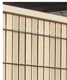
Le kit comprend 45 lames standard de largeur 48 mm, 3 profils vés à mettre dans les plis du panneau et 2 lames réduites de largeur 44 mm pour les extrémités afin de permettre de fixer le panneau sur le poteau. Les lames sont reprises sur le panneau dans un profil de finition haut et un profil de réception bas en pvc de couleur assortie.
