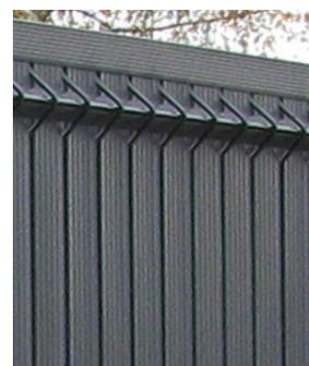
Le kit comprend 44 lames standard de largeur 48 mm, 3 profils vés à mettre dans les plis du panneau et 2 lames réduites de largeur 44 mm pour les extrémités afin de permettre de fixer le panneau sur le poteau. Les lames sont reprises sur le panneau dans un profil de finition haut en pvc de couleur assortie et dans des clips individuels bas translucides.
